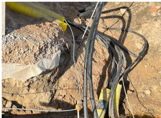
Joonis 2. Vahemik alajaama sisseviikude ning kaablite kaitsetorude vahel.
